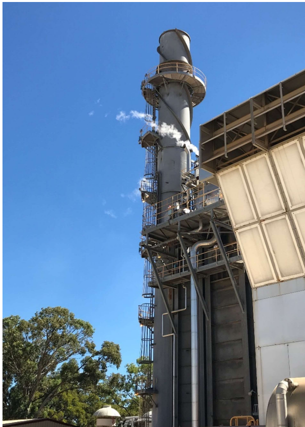
Figure 21: GT/HRSG stack
